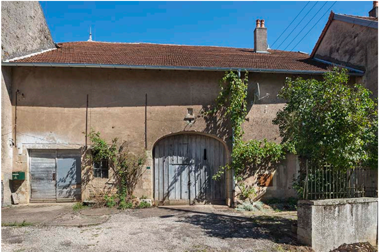
La porte cochère de la grange.
