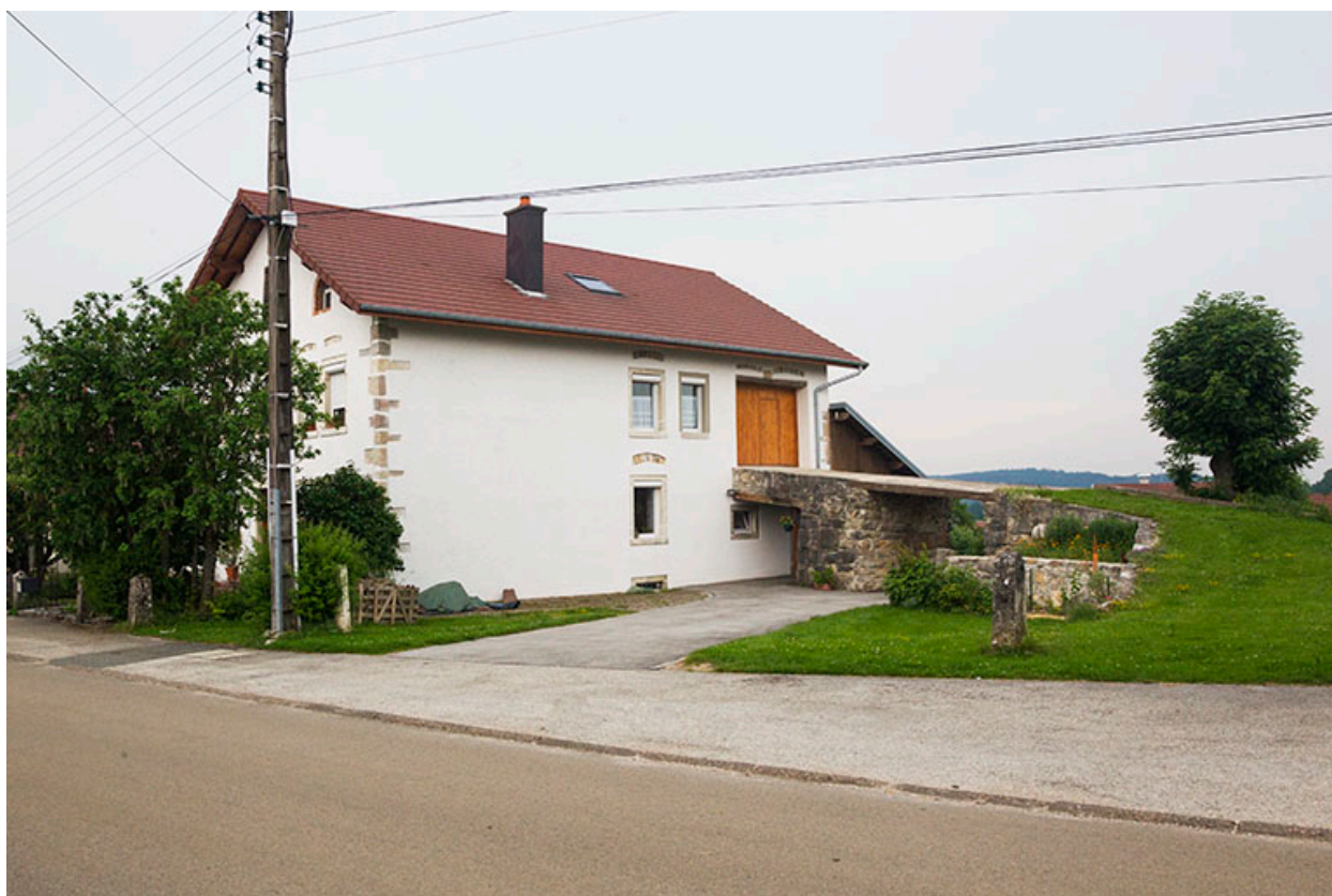
Façade latérale droite et pont de grange.
