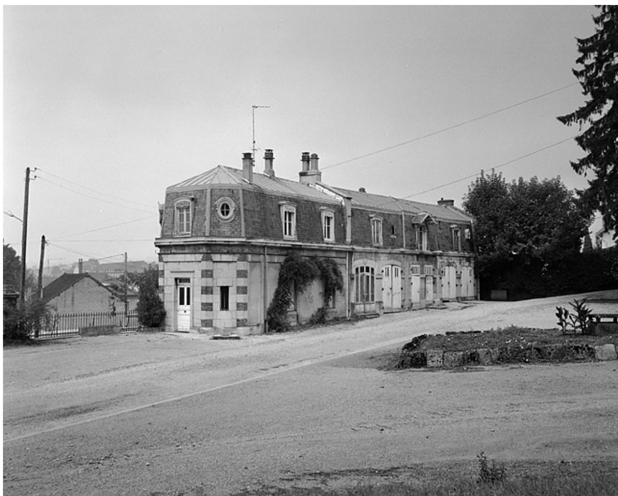
Bureau, logement et chai est.
