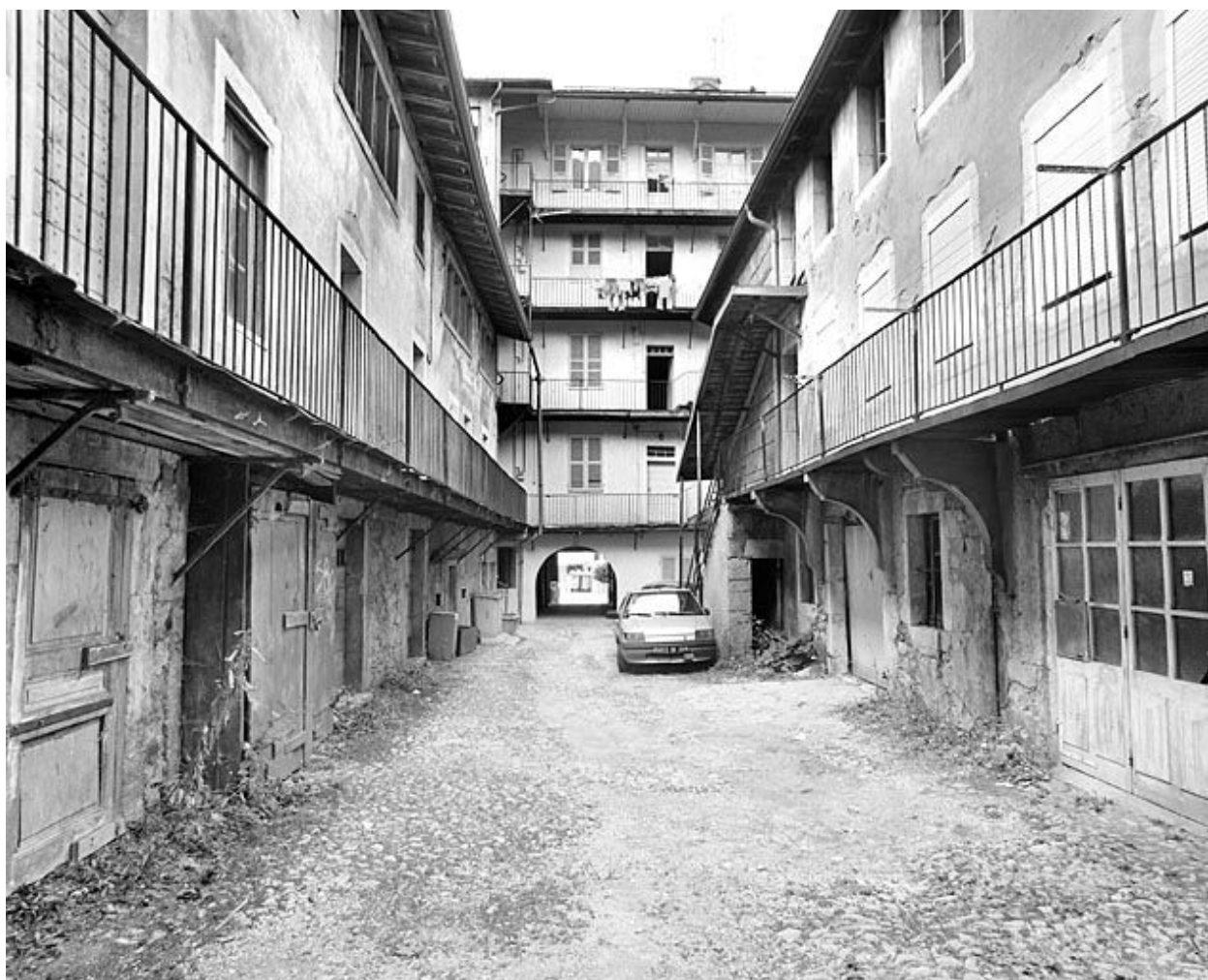
Cour et élévation postérieure.
