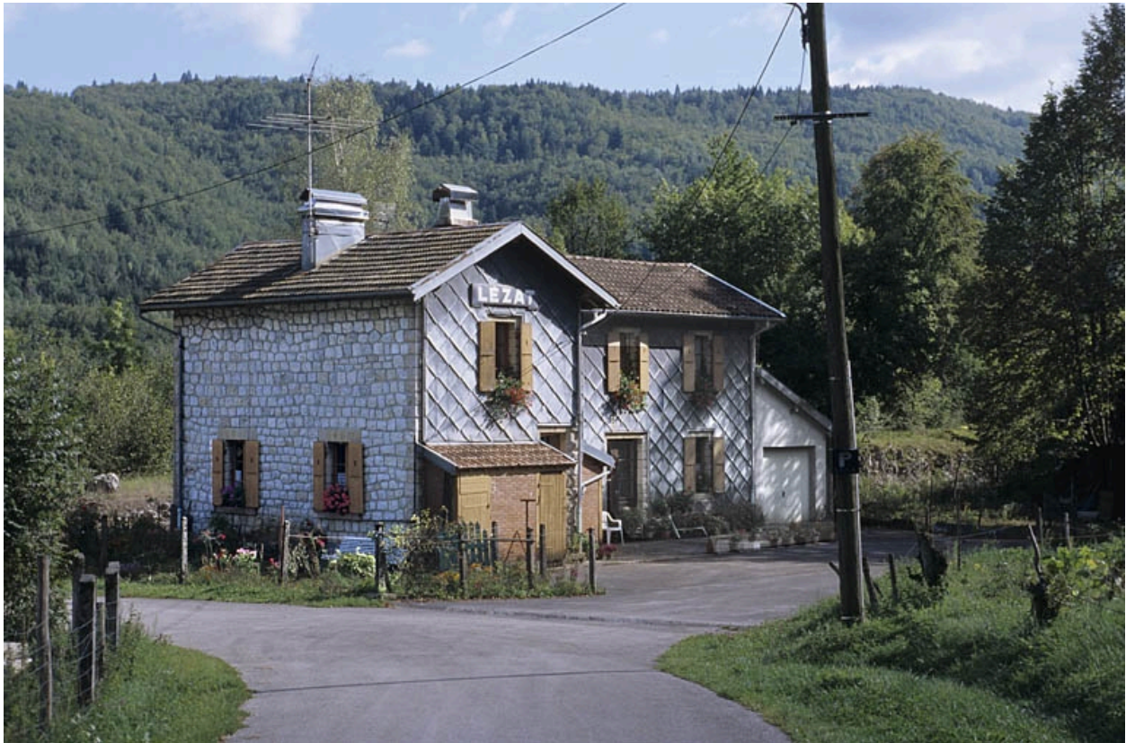
Façades antérieure et latérale gauche.
