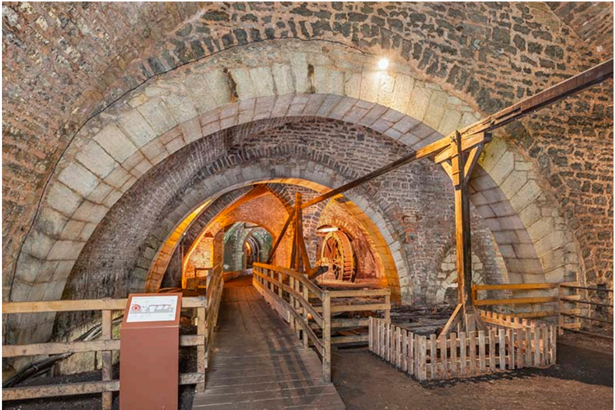
Puits d'Amont. Vue rapprochée sur le mécanisme hydraulique.
