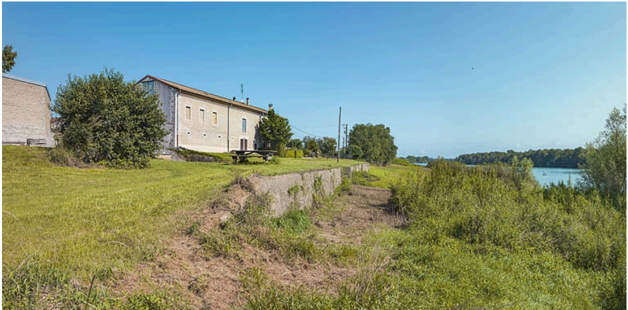
Mur de soutènement du port de Farges.
