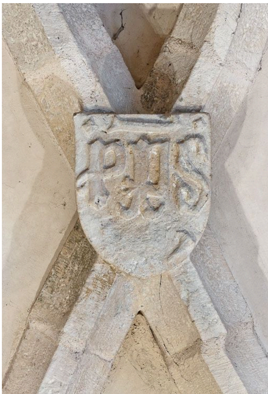
Clef de voûte de la première travée du bas-côté droit.
