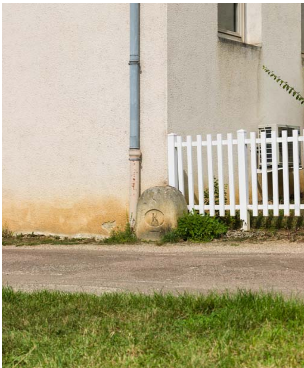
Vue d'ensemble de la borne.
