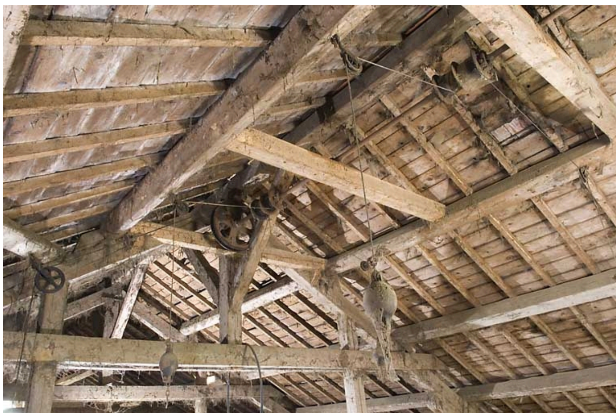
Grange haute : poulies et contrepoids de la déchargeuse dans la charpente.
