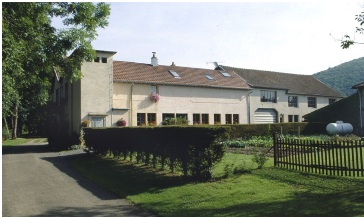
Atelier de fabrication nord depuis la rue.
