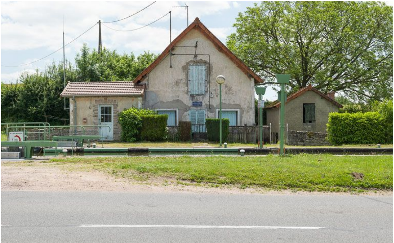
Vue de face de la maison éclusière.
