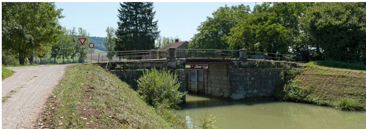
Vue du pont depuis l'amont.
