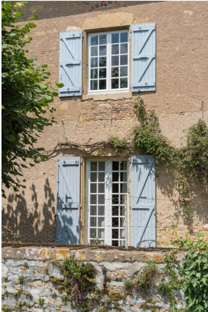
Détail de la façade antérieure de la maison : baie du rez-de-chaussée et de l'étage
