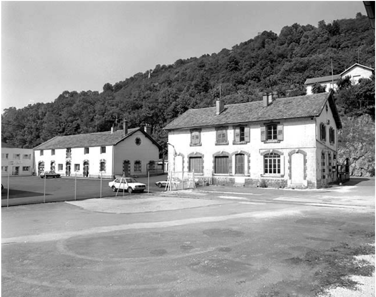
Usine B : entrepôt de matériel et logements.
