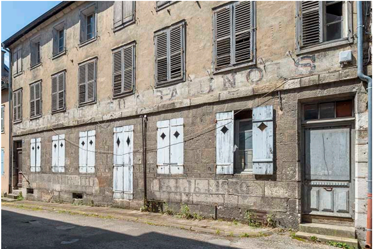
Façade postérieure (rue d'Orgemont). Partie inférieure.
