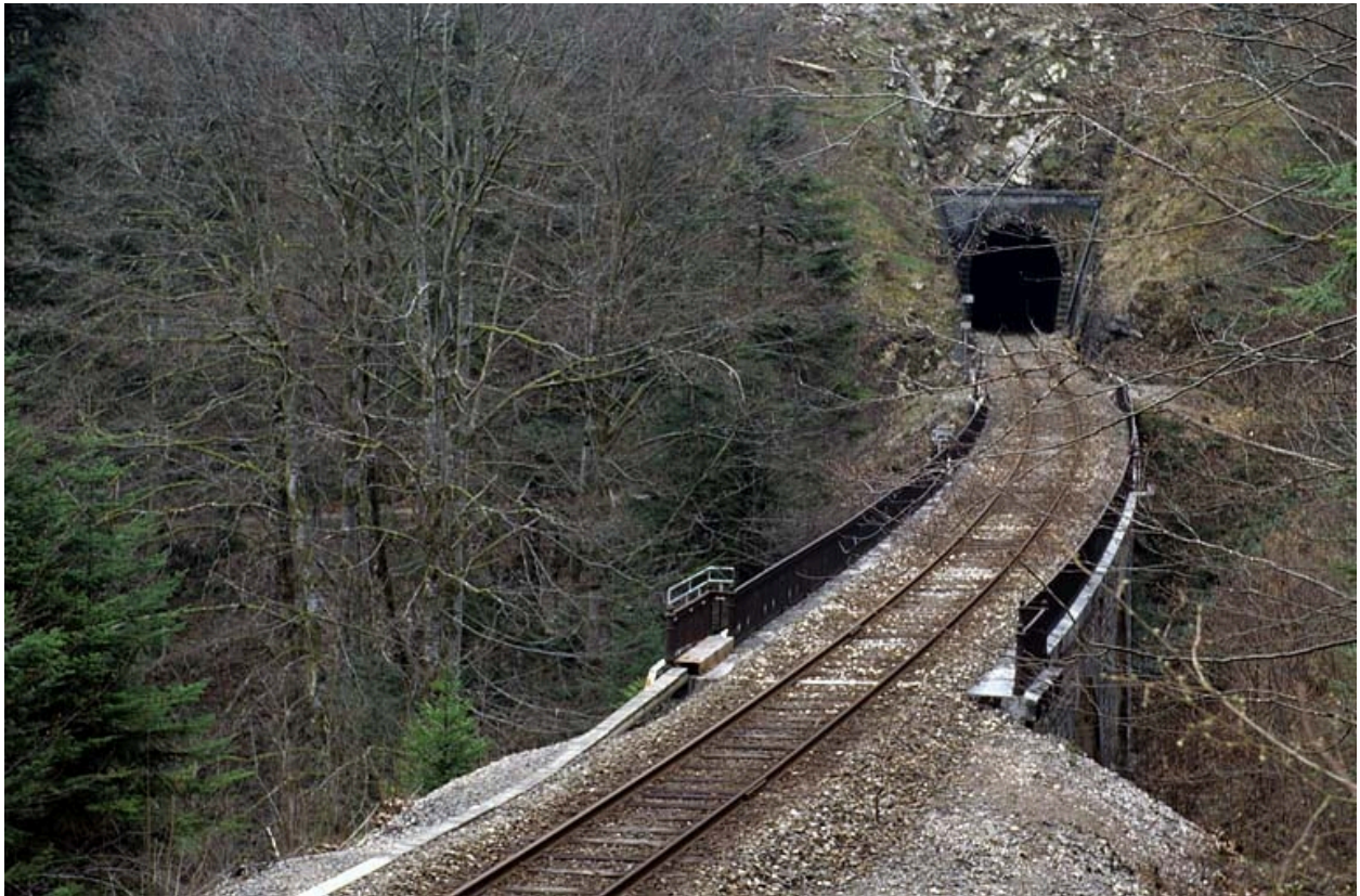
Viaduc : vue d'ensemble, depuis le nord-ouest (côté Andelot-en-Montagne).
