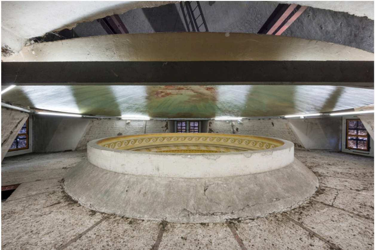
Extrados de la coupole, surmontée de la calotte peinte.
