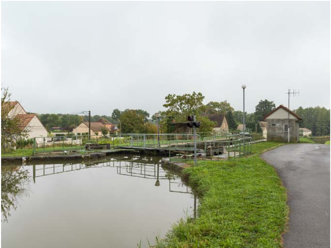
Vue d'ensemble du site d'écluse.
