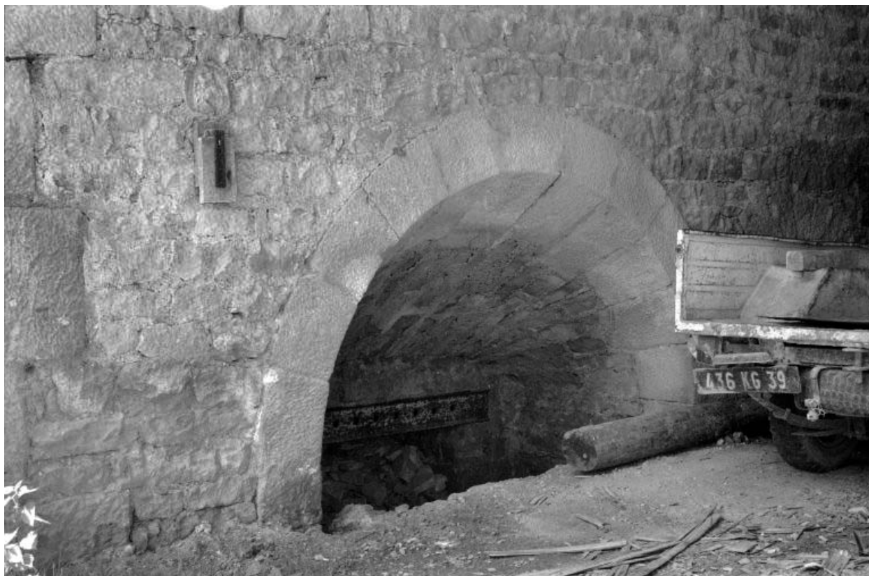
Ouverture de défournement nord.
