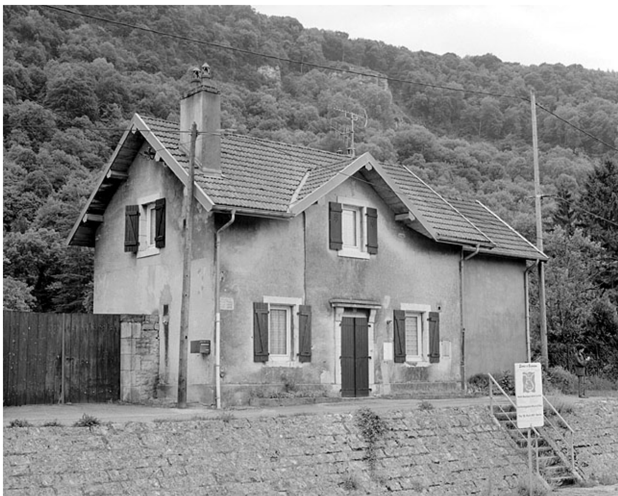
Maison d'éclusier, de trois quarts gauche.
