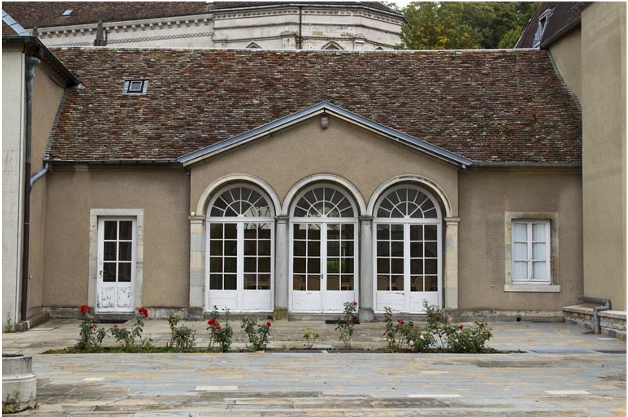
Orangerie : vue d'ensemble de la façade antérieure.
