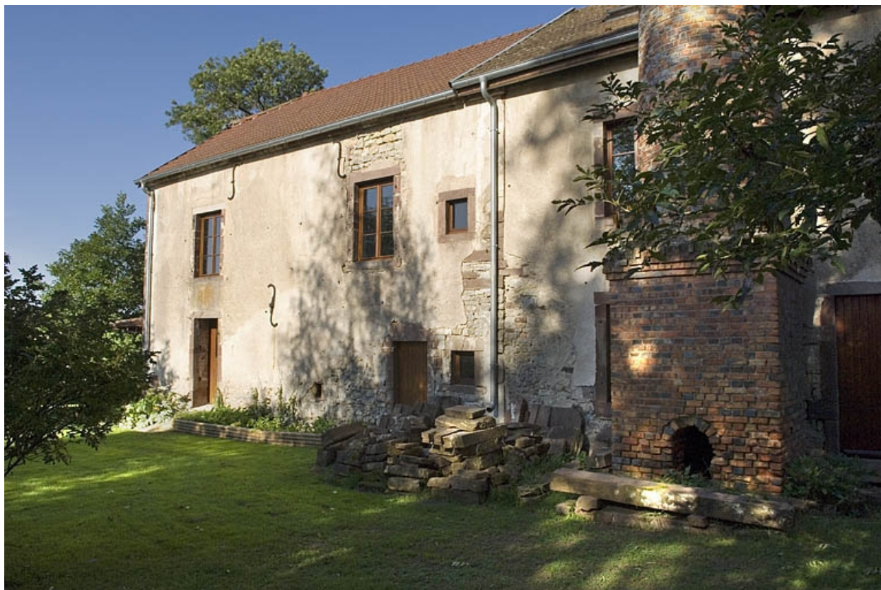
Partie sud (logement) de la façade postérieure.
