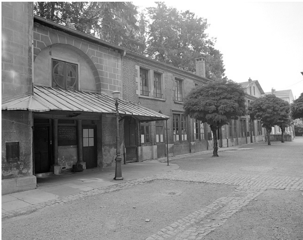
Bâtiment annexe, vue d'ensemble.
