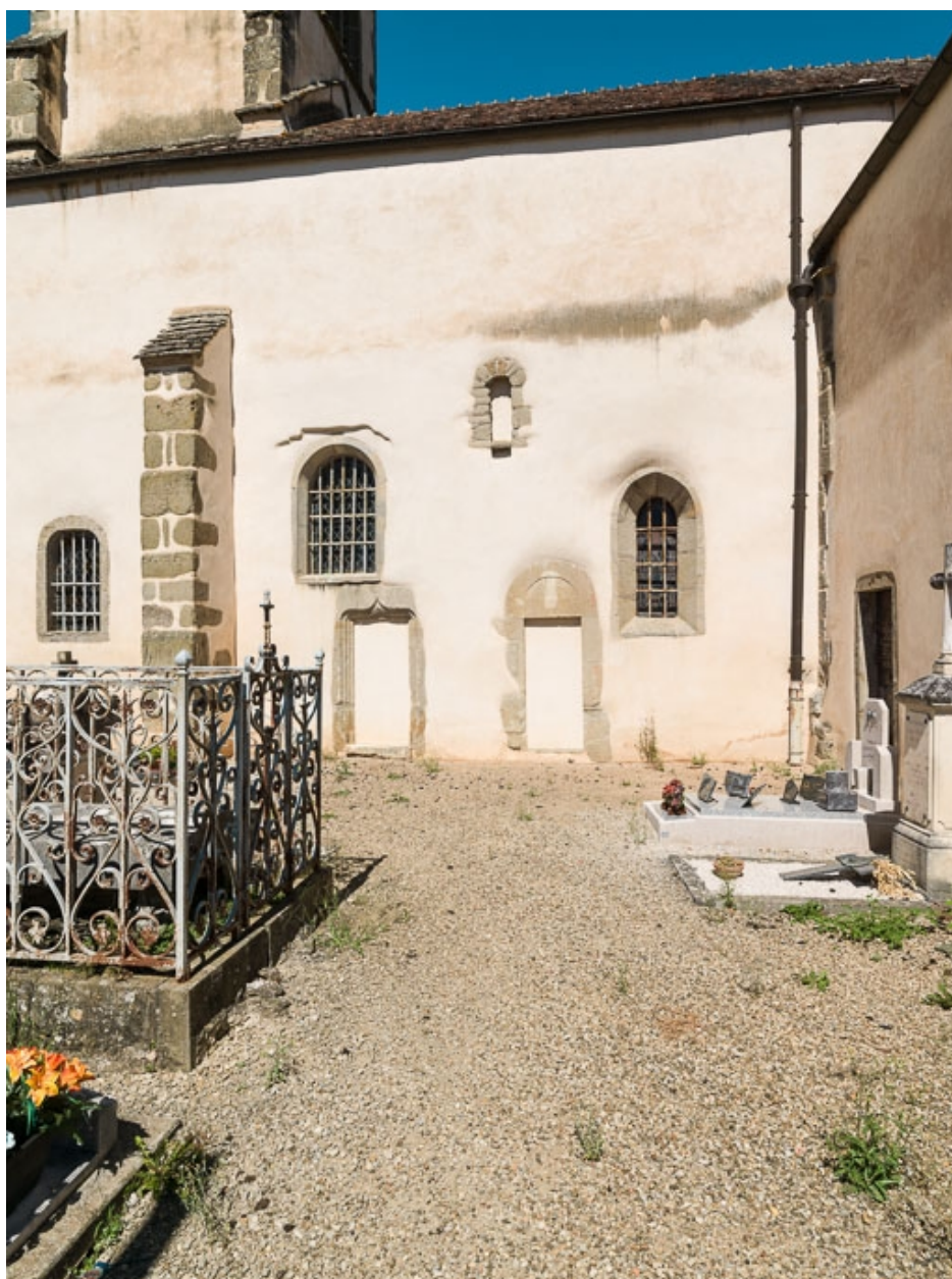
Elévation sud de la nef.
