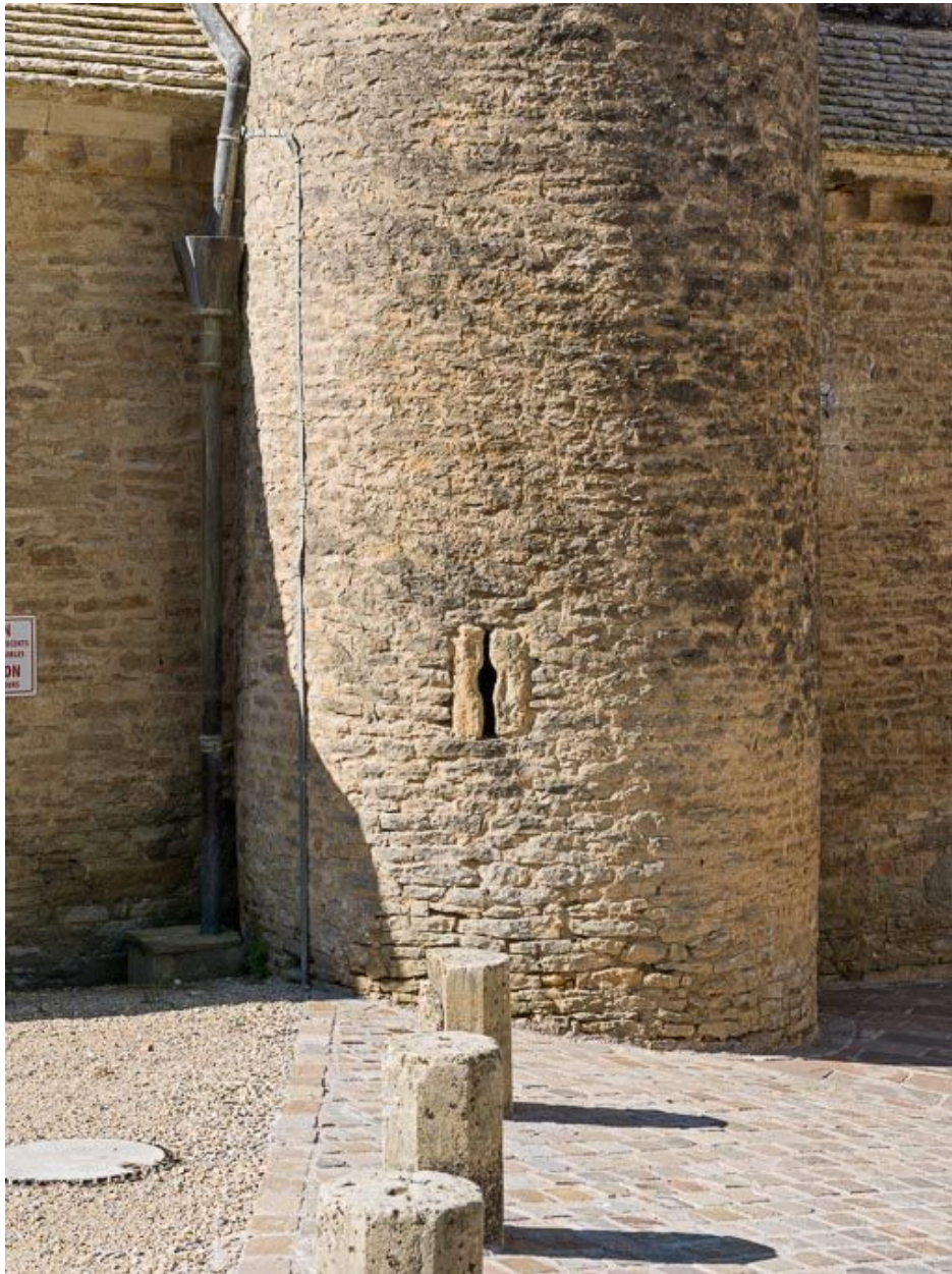
Tourelle d'escalier : détail du jour en archère.
