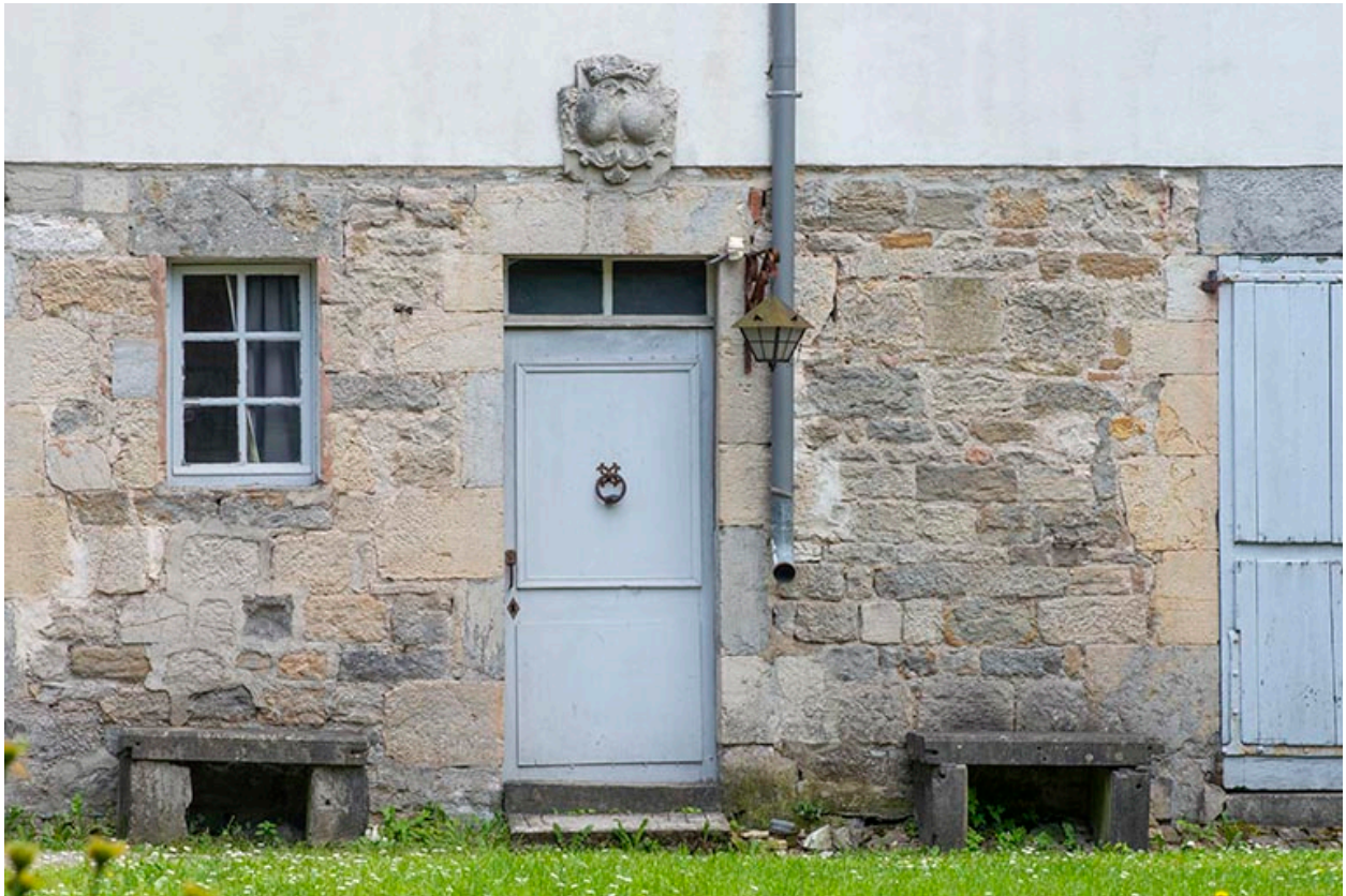
Détail du mur nord des communs.
