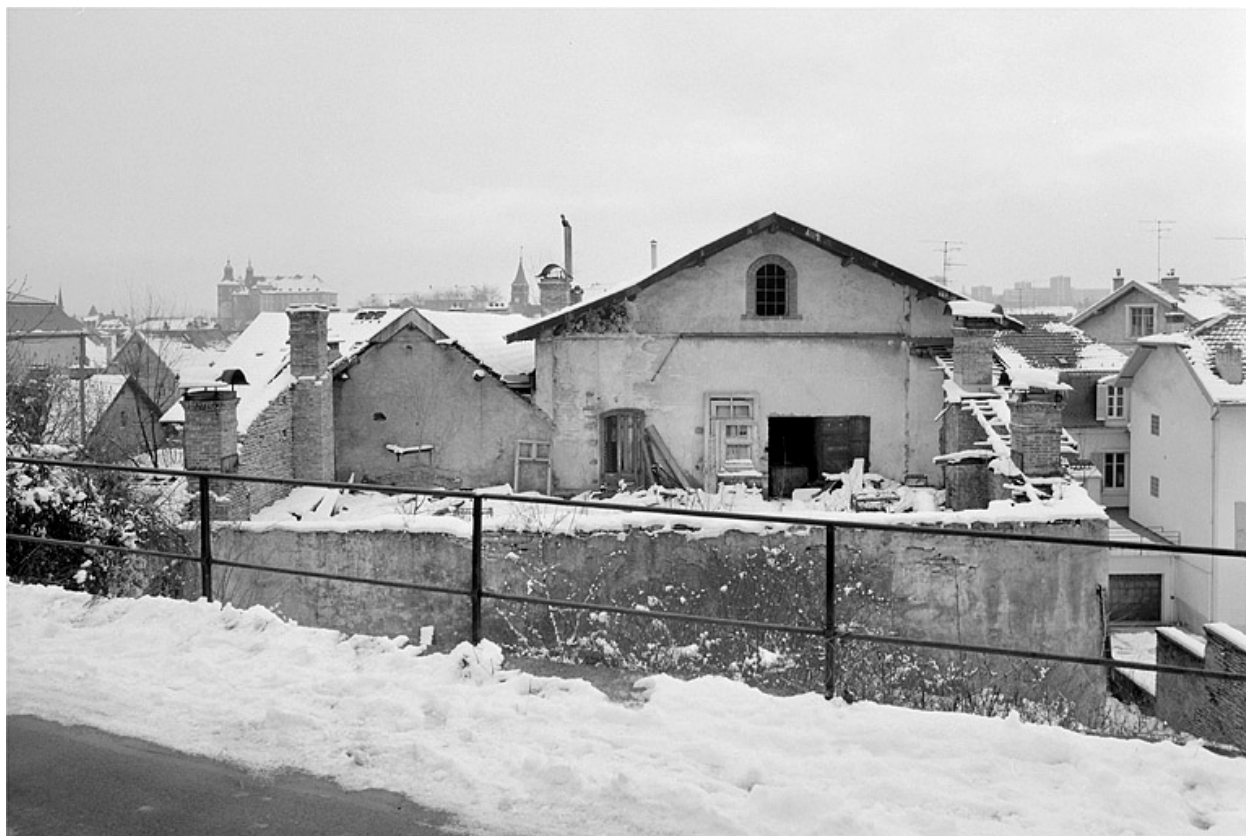
Pignons, côté nord.
