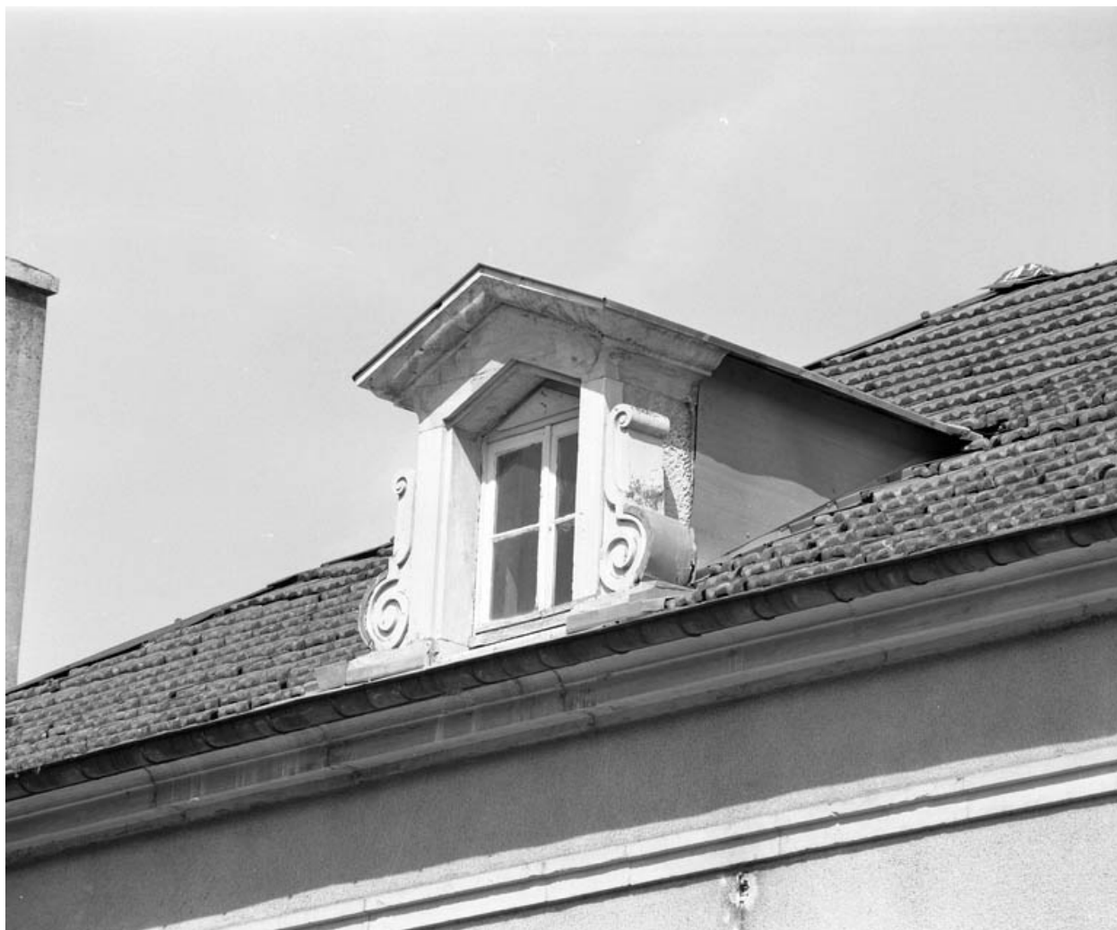
Détail d'une lucarne.
