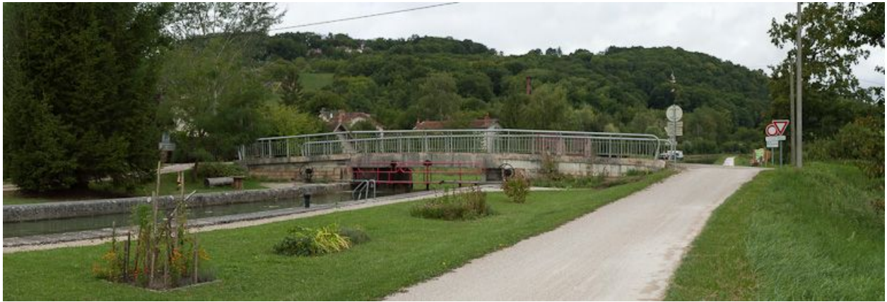
Vue du pont depuis l'amont.
