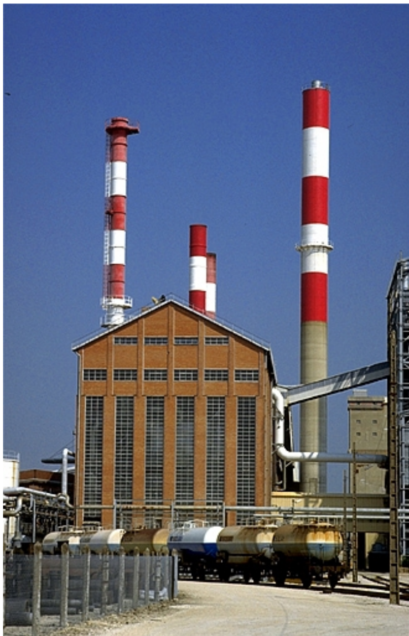
Façade postérieure du bâtiment des générateurs de vapeur et d'électricité.
