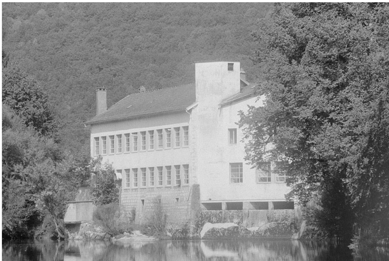
Atelier de fabrication, depuis le sud-est (amont).
