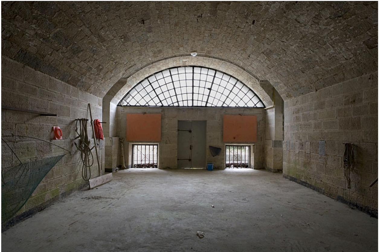
Intérieur d'une casemate : baie.
