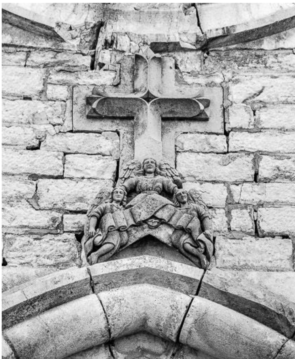
Extérieur : portail, façade antérieure, détail.
