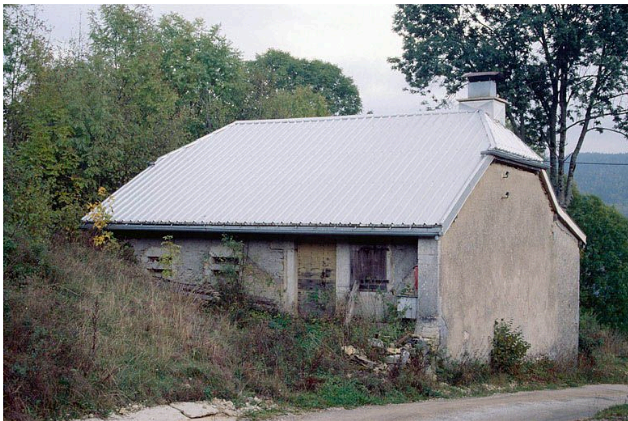
Fromagerie, vue de trois quarts droit.
