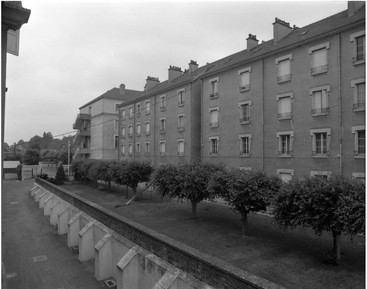
Partie droite de l'ancienne caserne : vue de la cour de trois quarts droit.
