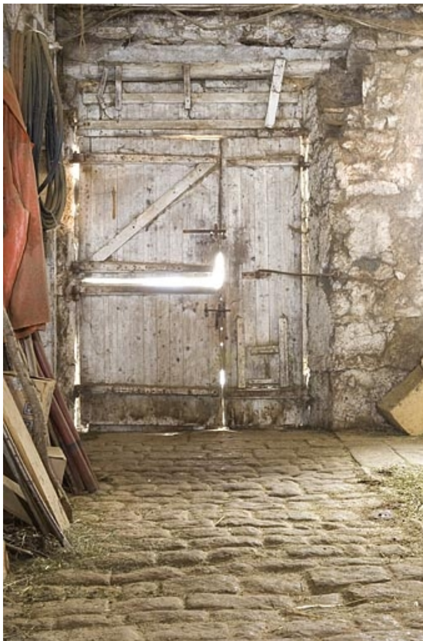
Etable : la porte vue de l'intérieur.
