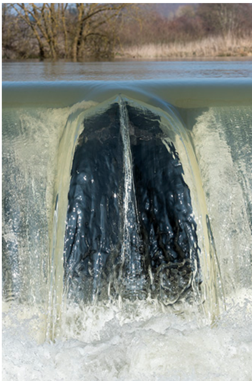
Vue rapprochée du barrage.
