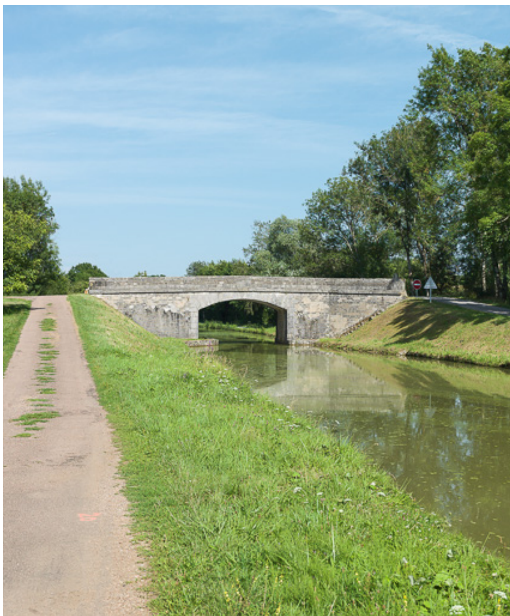
Vue d'ensemble du pont.
