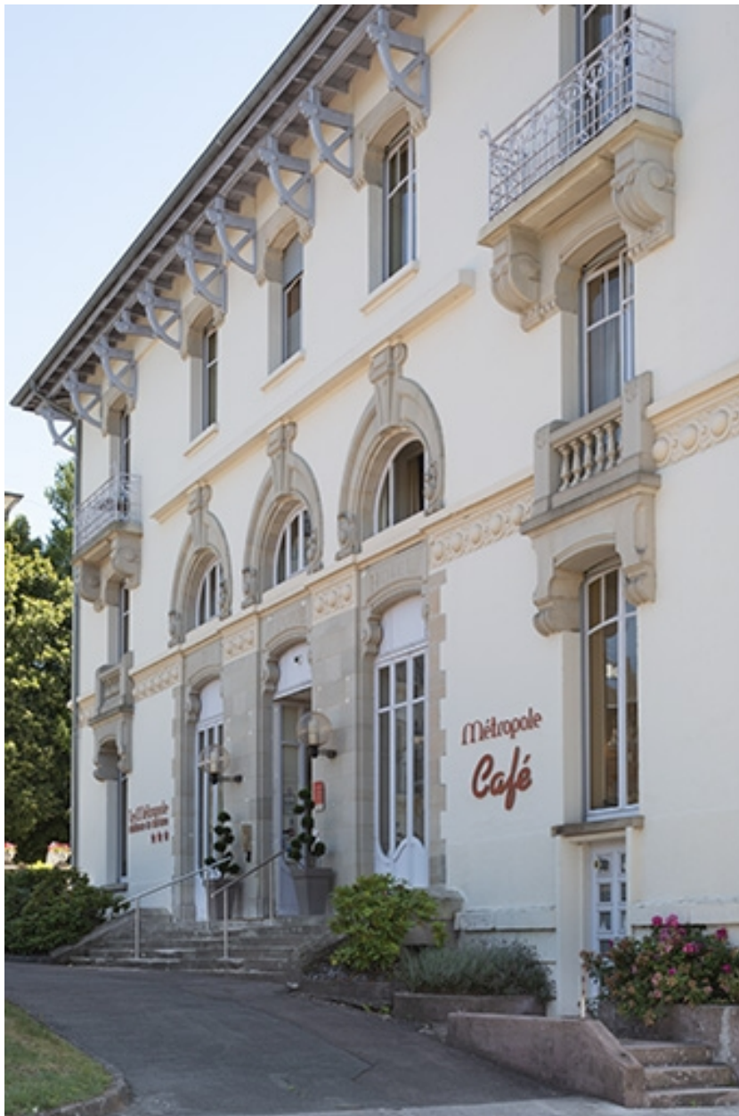
Façade nord, vue de trois quarts, détail.
