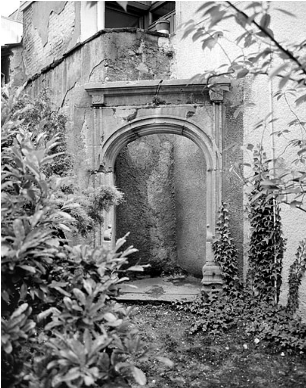
Portail provenant d'une maison détruite rue du Château.
