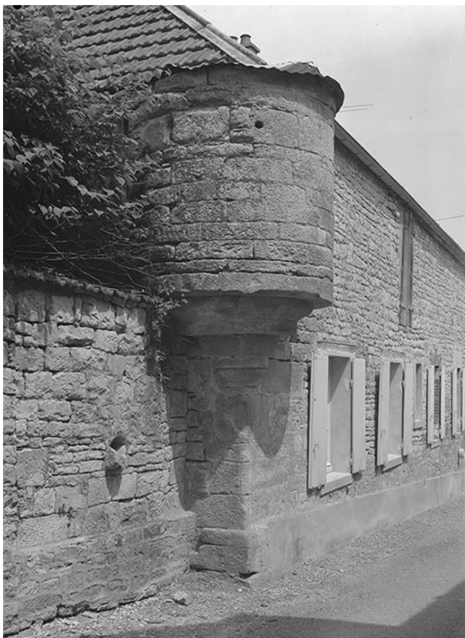
Tourelle en surplomb.
