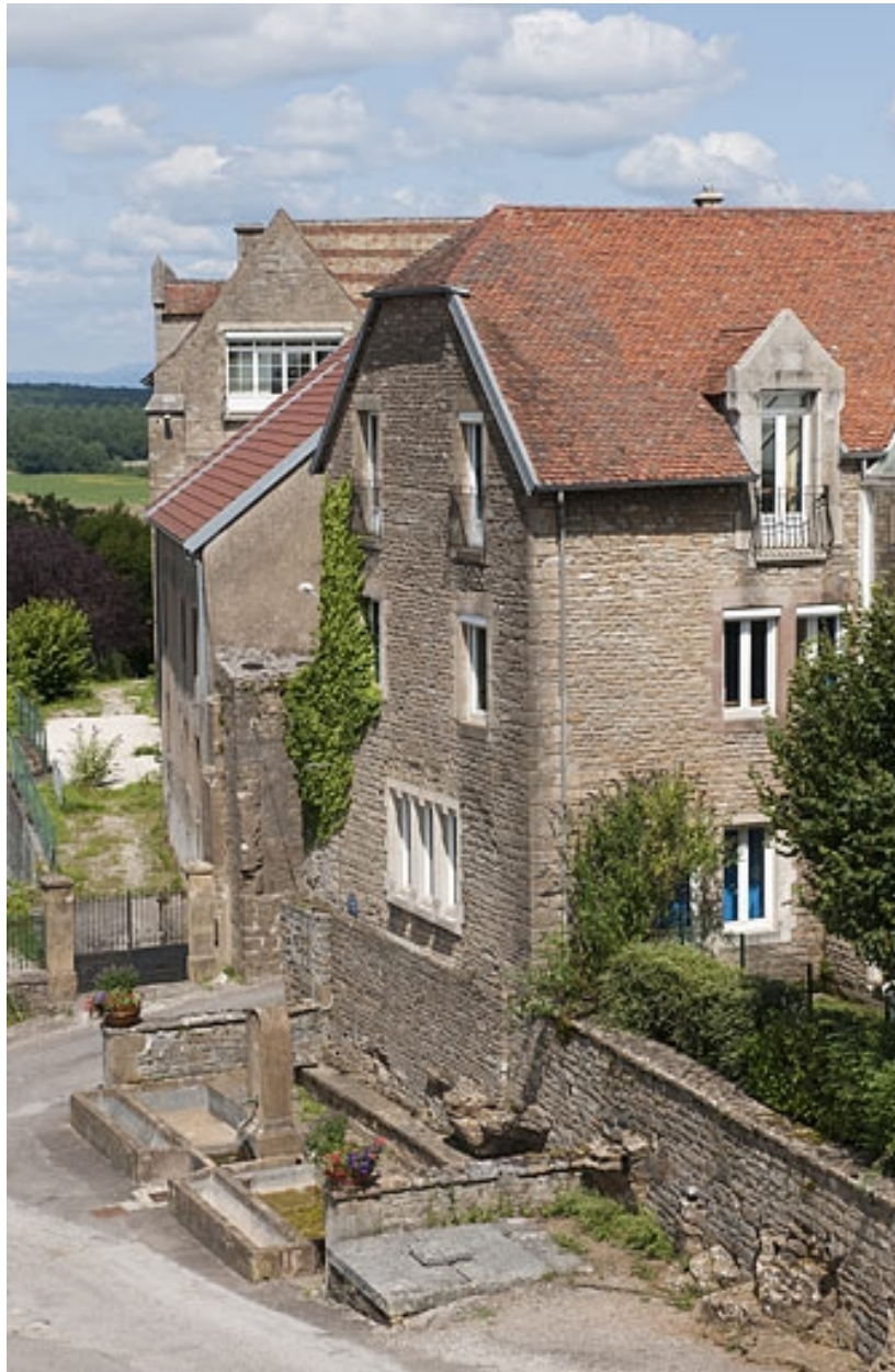
Bâtiment (A), vue rapprochée du côté rue.
