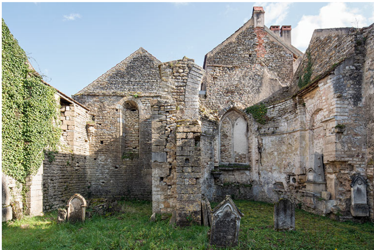
L'ancienne église, en direction de l'est.
