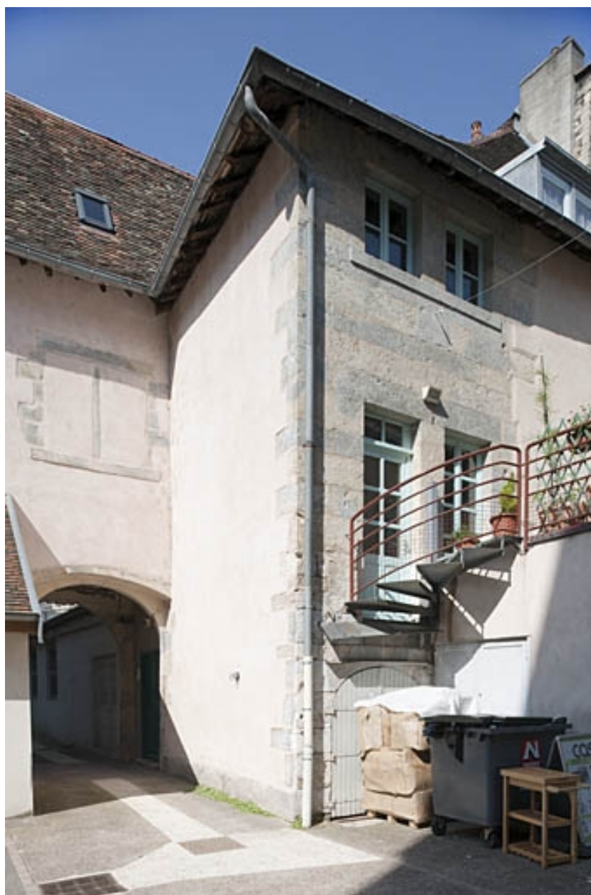
Façade postérieure du logis principal, partie droite.
