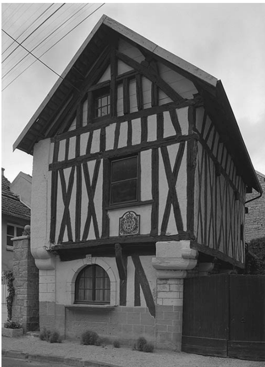
Mur-pignon sur rue.
