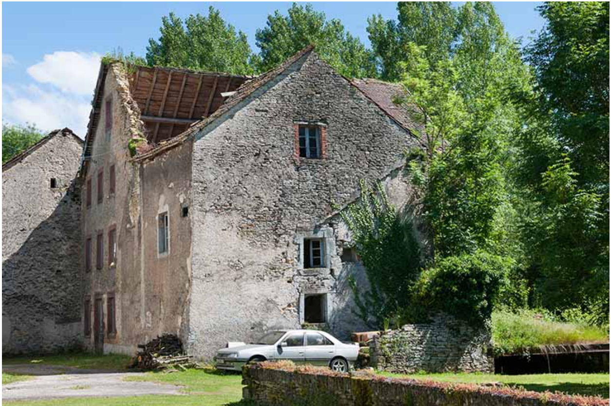
Le moulin depuis le nord-ouest.
