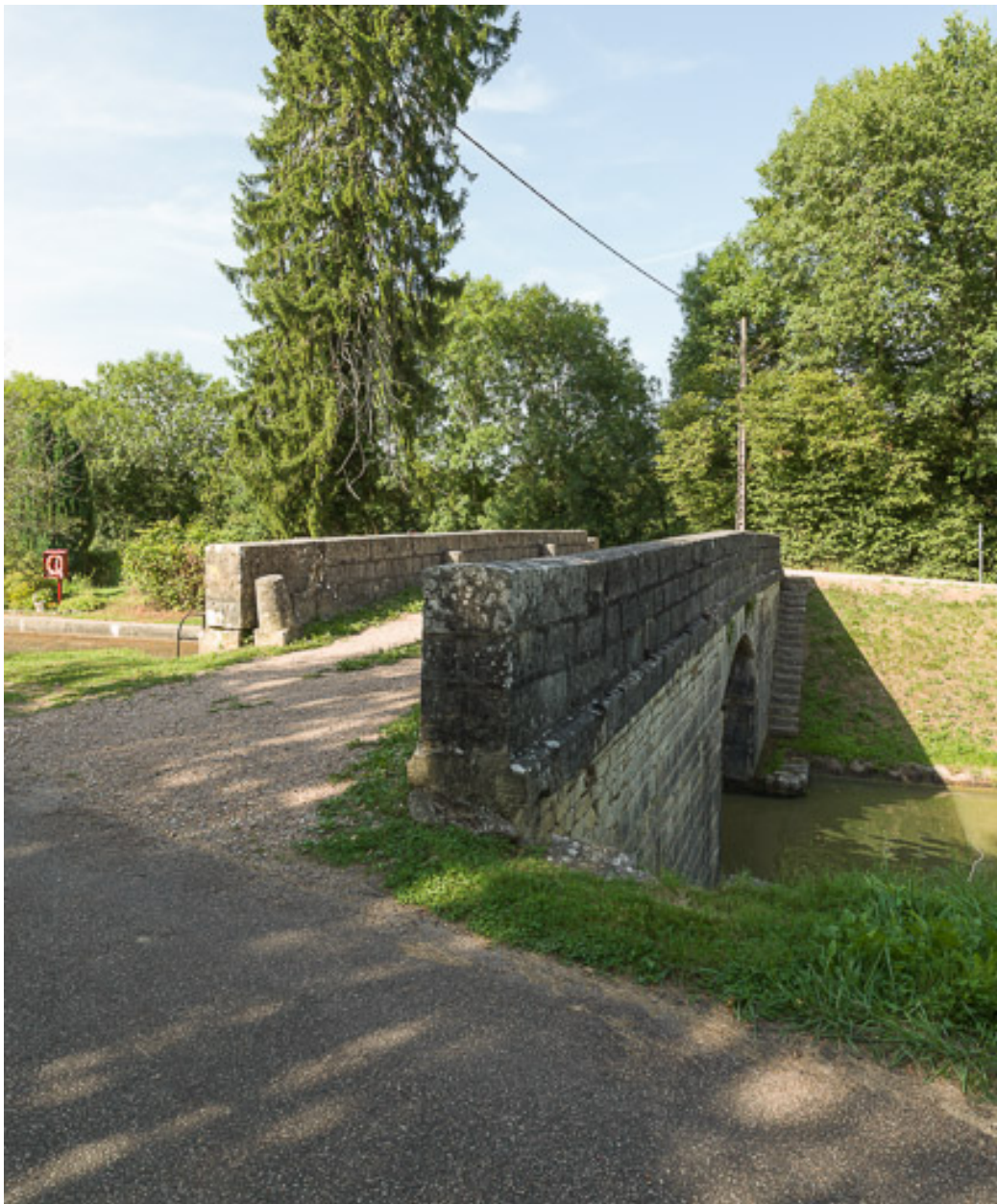
Vue du pont.
