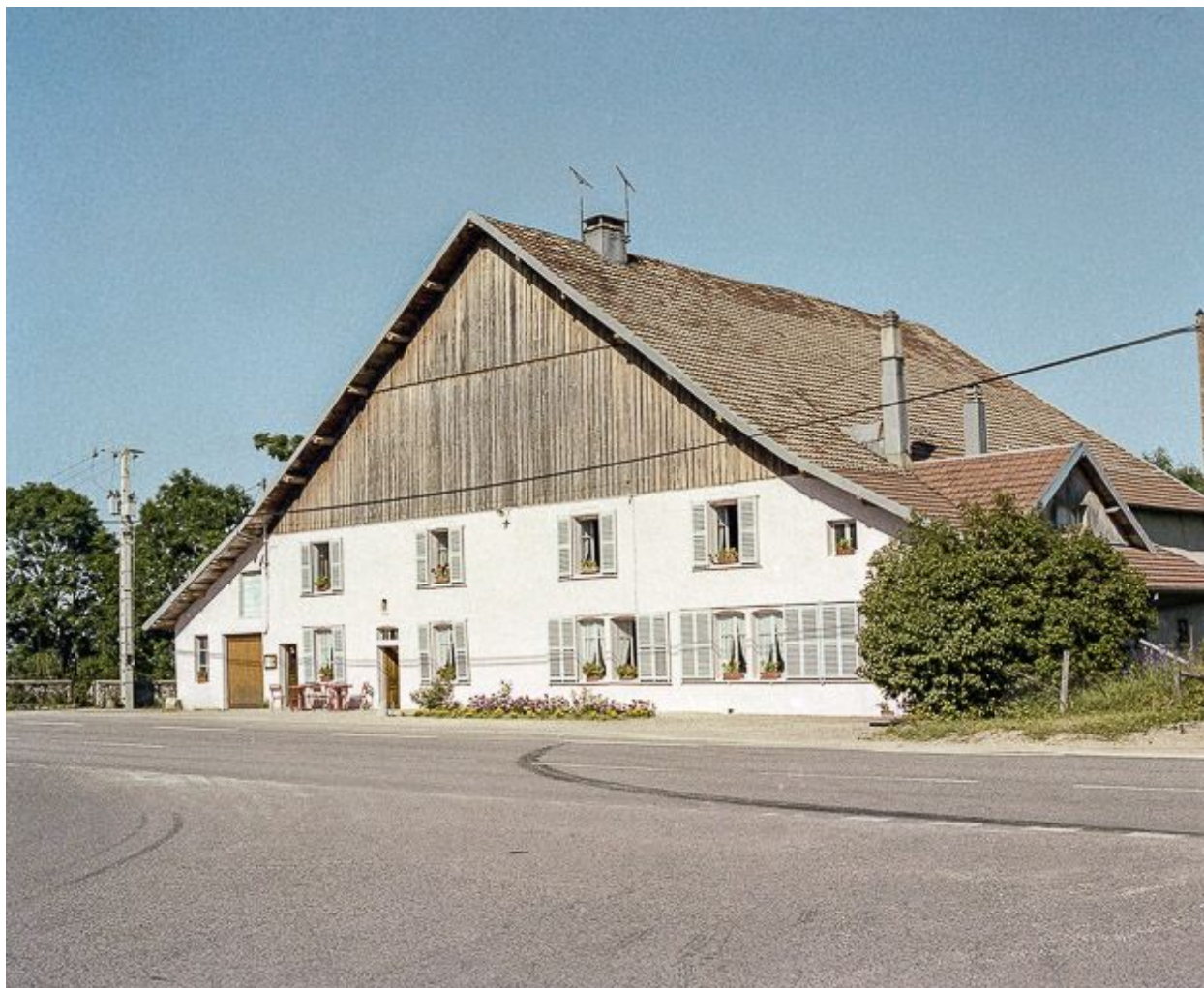
Ferme située au lieudit La Morelle.
