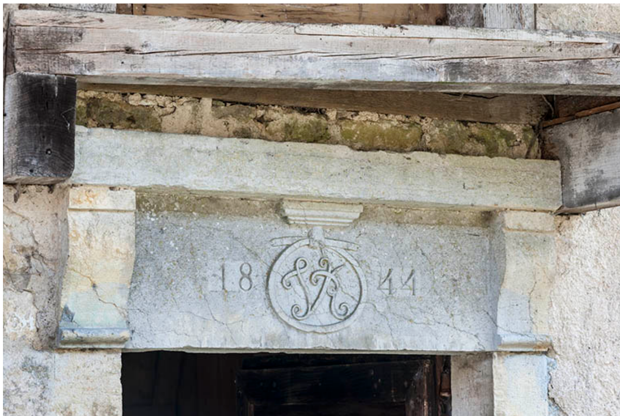
Mur-pignon ouest. Détail du linteau.
